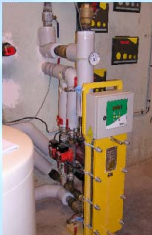
Echangeur à plaques
